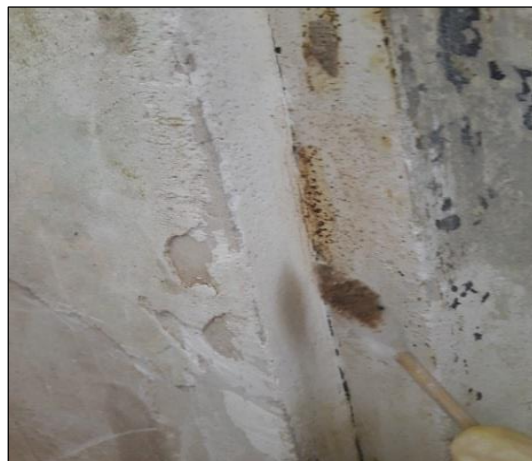
تصویر ۸. پاک‌سازی رسوبات عمیق به وسیله ترکیب (تربانتین+اتانول)
