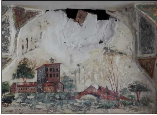
تصویر ۱۰. کشیدن گچ روی سطح آجر و هم سطح کردن
