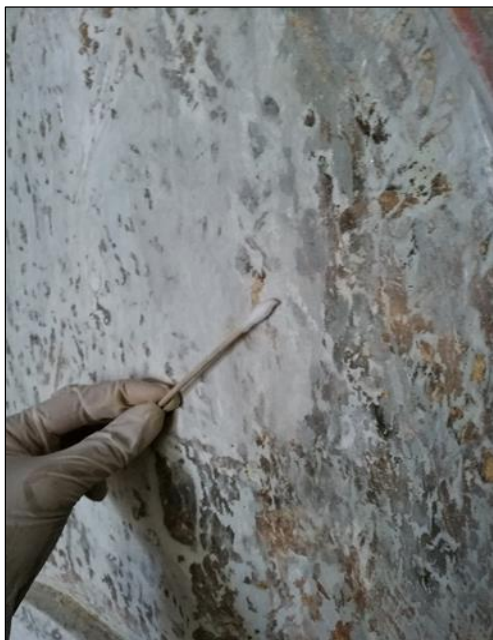
تصویر ۷ و ۸. تلفیق لایه‌برداری مکانیکی و شیمیایی
