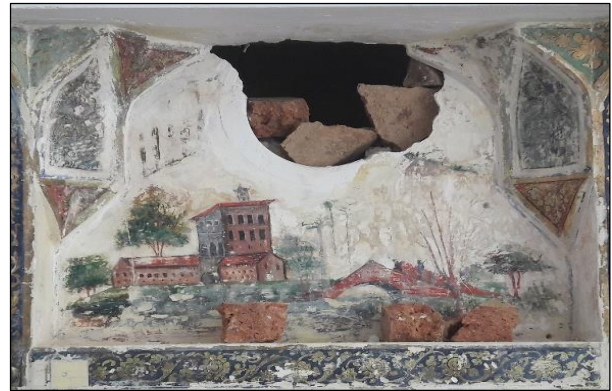
تصویر ۹. قرار دادن تکه های آجر به عنوان تکیه گاه
